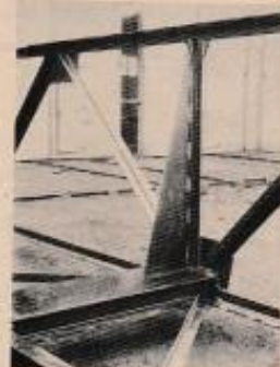
Rys. 50. Stropki stalowe spawane.
