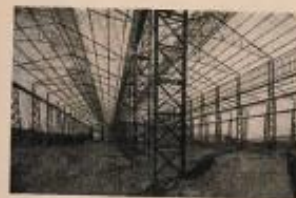
Rys. 42. Dach kratowy (konstrukcja spawana).
