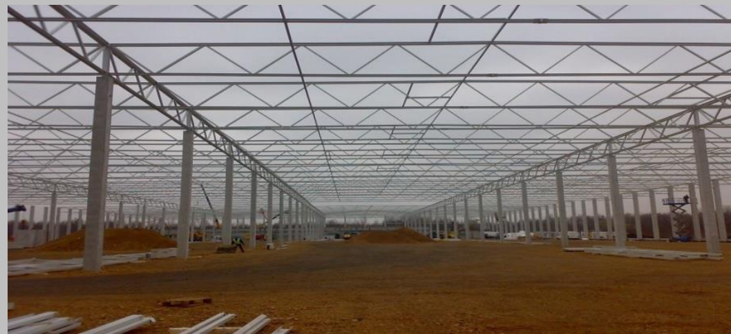
Hala Produkcyjno – Magazynowa WATT w Sosnowcu, 190 ton
