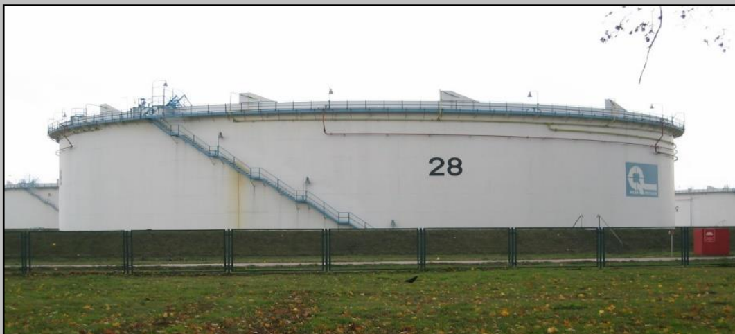
Zbiornik paliwa Plebanka, V=100\ 000\ m^3 , 2.000 ton
