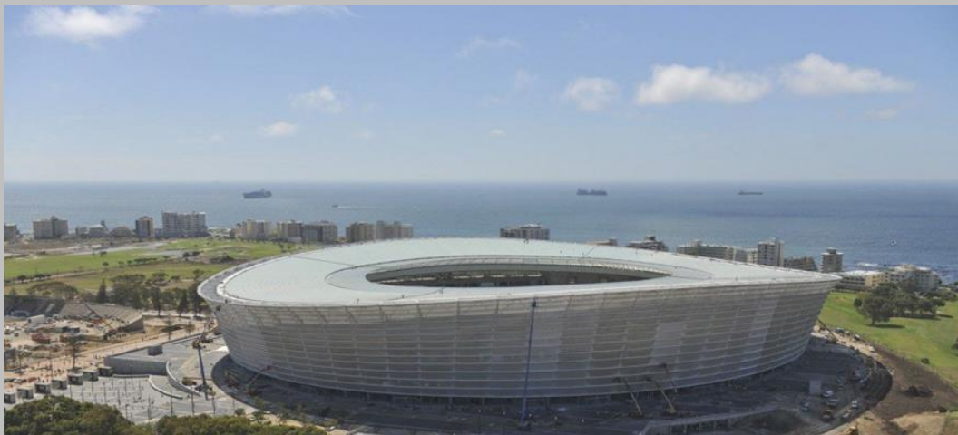
RPA – Stadion Green Point w Kapsztadzie, 1.600 ton
