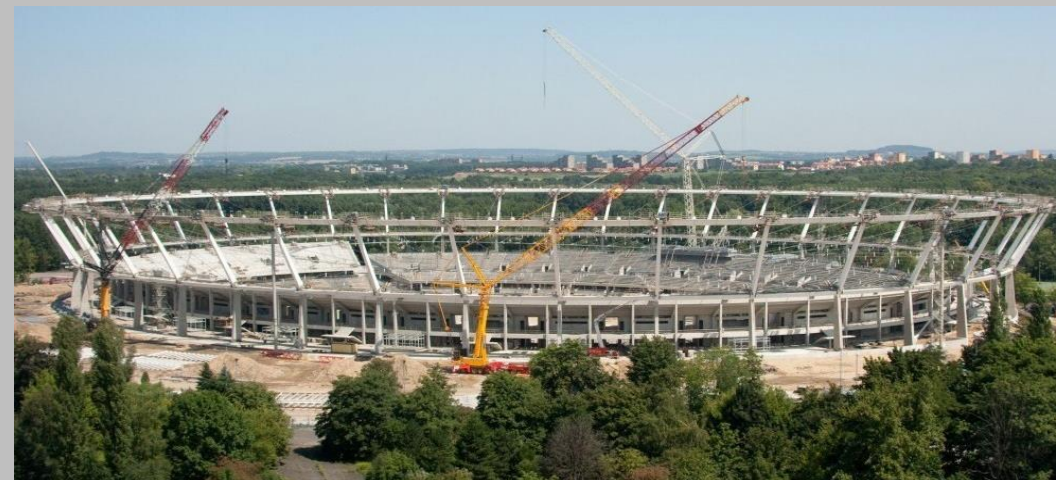
Stadion Śląski w Chorzowie - Zadaszenie widowni, 7.010 ton.
