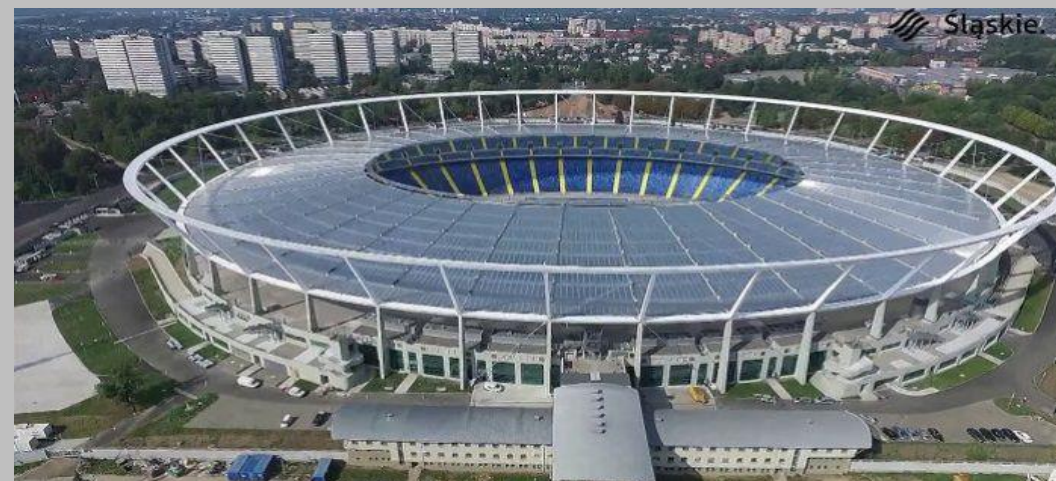
Stadion Śląski w Chorzowie - Zadaszenie widowni, 7.010 ton.
