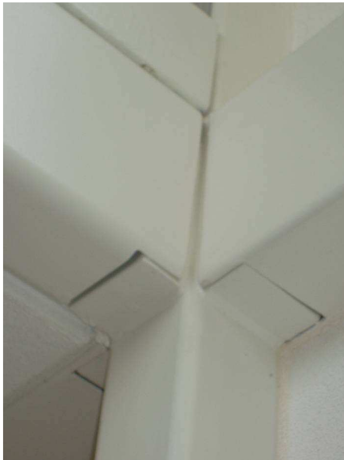
Rys. 1.1 „Ukryte” połączenie elementów rurowych
