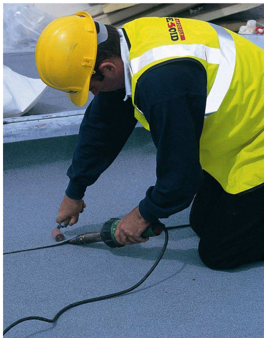
Rys. 3.4 Złożone bitumiczne membrany łączone za pomocą gorącego powietrza (Fotografia udostępniona grzecznościowo przez Ruberoid)
