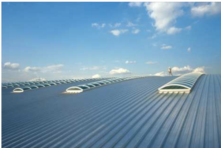
Rys. 2.12 Stojące szwy lub ukryte mocowanie arkuszy
