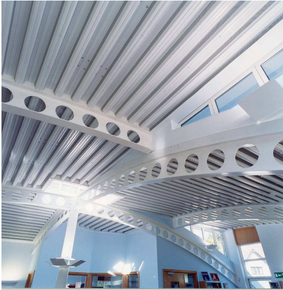
Rys. 2.6 Dach ze stojącym szwem blachy górnej i belkami ażurowymi podpierającymi dolną nośną blachę fałdową, razem z wełną mineralną dostarcza pochłanianie dźwięku w bibliotece (Fotografia udostępniona grzecznościowo przez Corus Profiles & Panels)
